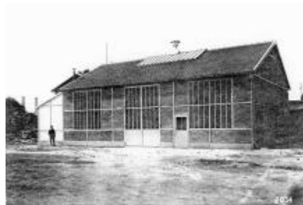
Bâtiment abritant la soufflerie à Argenteuil. (Cliché Musée de l'Air).
